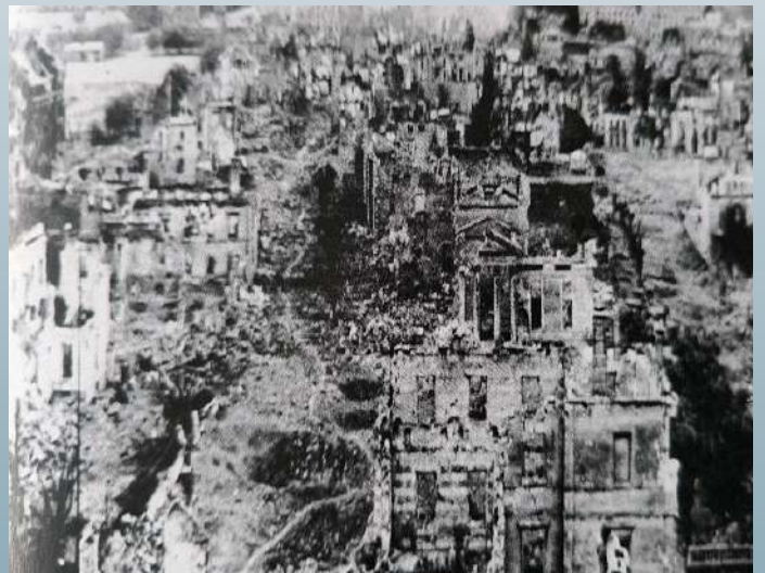
SAINT-LO – Capitale des ruines.
